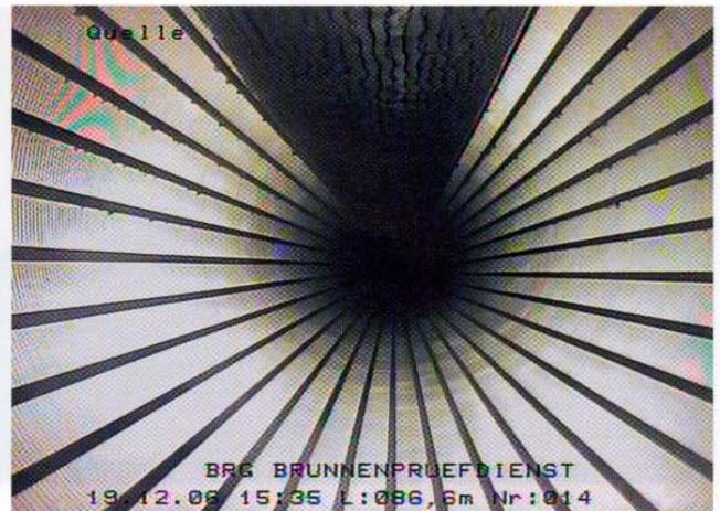
Abb. 7 VA-Wickeldrahtfilter einer Quellfassung – Bauabnahme
