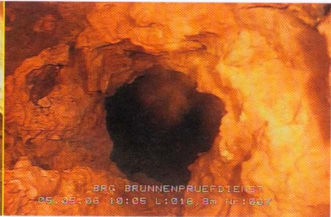
Abb. 5 Horizontalfilterstrang vor der Regenerierung
